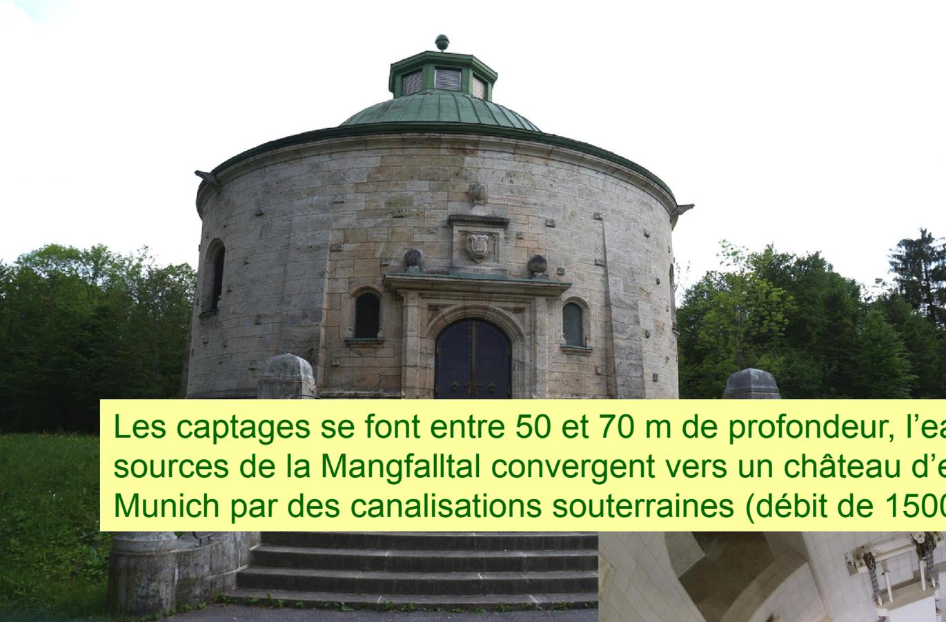
Les captages se font entre 50 et 70 m de profondeur, l'eau issue des 6 sources de la Mangfalltal convergent vers un château d'eau, puis vers Munich par des canalisations souterraines (débit de 1500 l/s )
